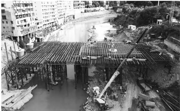
筑岛围堰、旧桥拆除、桩基、桥墩、桥台、东侧及西侧桥台围护桩等均已完工;贝雷架施工已完成90%。
