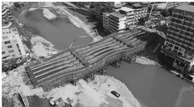
梅溪大桥改造施工现场航拍。(记者 黄东)
