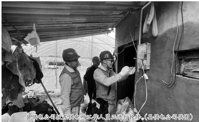
县供电公司坂东供电所工作人员正在进行检修。(县供电公司供图)
