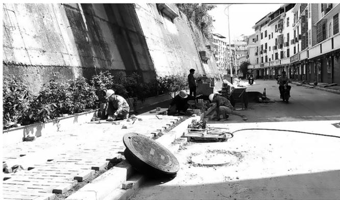
**本报讯** 8月13日,记者在闽清县梅溪路看到,许多工人顶着大太阳在紧张地忙碌着,有的在拆除路缘石的铺装,有的在拆除路面井盖的拆除更换,有的在做人行道的铺砖,路面虽然较为凌乱,但是现场交通状况还是相对畅通。
