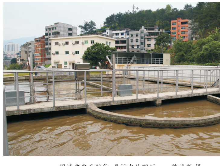
闽清广安天然气、县污水处理厂。 陈益新 摄
