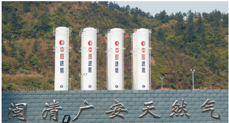
闽清广安天然气、县污水处理厂。 陈益新 摄
