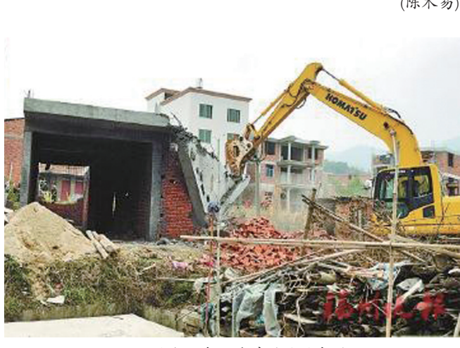
图为坂东一违建被依法拆除。
