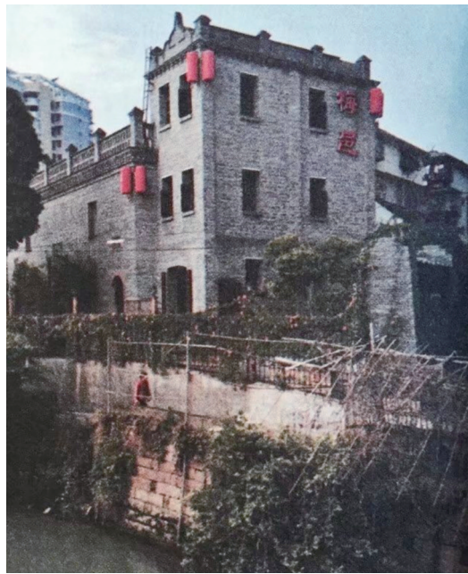
闽清会馆(原建筑)
