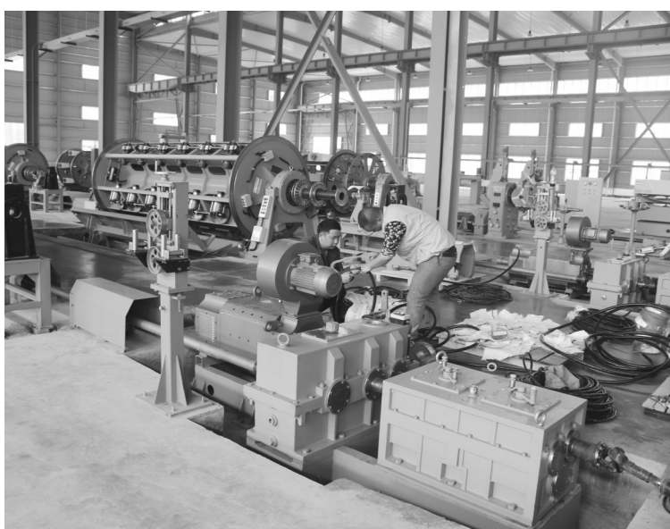
礼恩电视正在加快安装调试生产设备,力争近期开工生产。图为生产车间一派繁忙景象。(本报记者张永豪摄)
