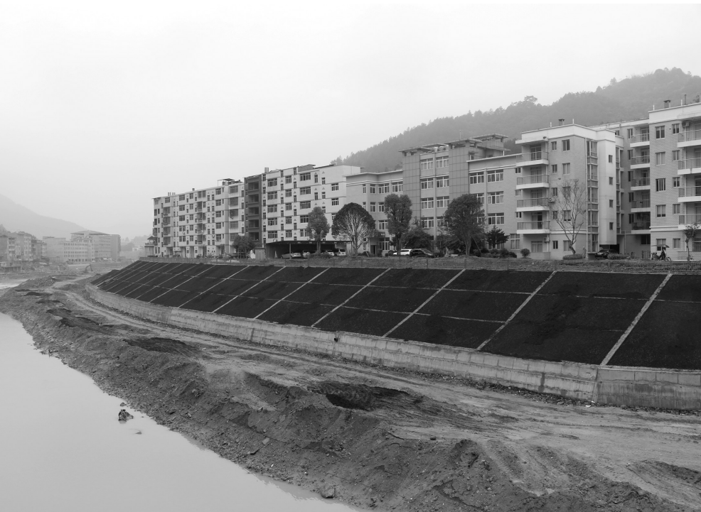
城区大路河段的防洪堤坝在今年汛期来临之前已完工。
