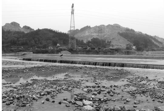
各乡镇的防洪灌溉工程应急工程在今年三月底前完工。图为白中芝溪梅洋拦河坝及渠道。
