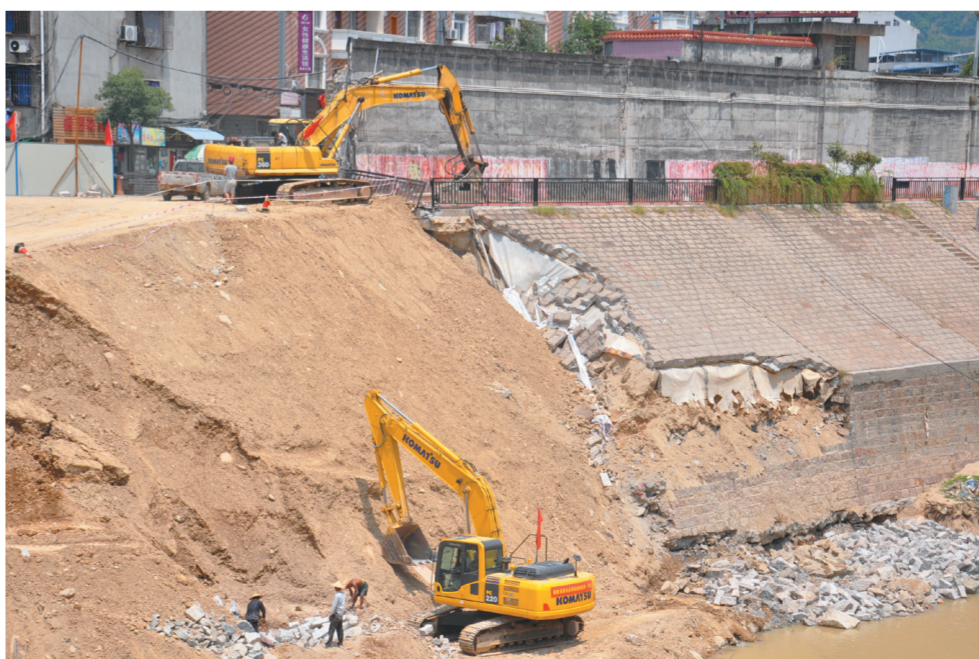
8月7日中午,施工正在对防洪堤进行加固修复
