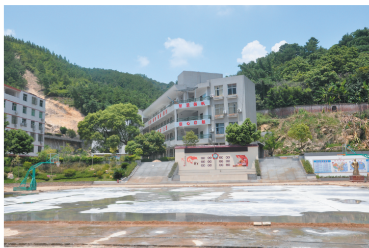
图为完成清淤工作的县教师进修学校第二附属小学
