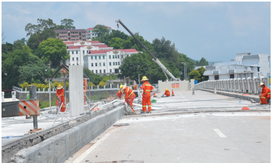
图为溪口大桥施工现场
