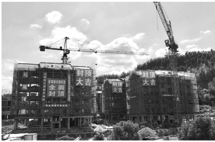
省城镇省镇村农村住房集中重建点11月2日晚全面封顶(如图)。
